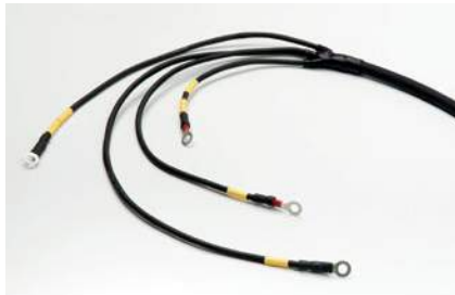
Кабель, обжаты кабельными наконечниками
